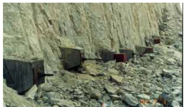
图 2 现场试验全貌
